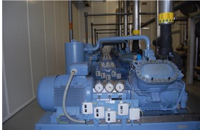
Bild Links: Eine Kälteanlage in einem Technikraum von einem Supermarkt; Bild Mitte: Kompressoren einer Kälteanlage mit Ammoniak, Bild Rechts: Eine Flasche mit dem Kältemittel Kohlendioxid
